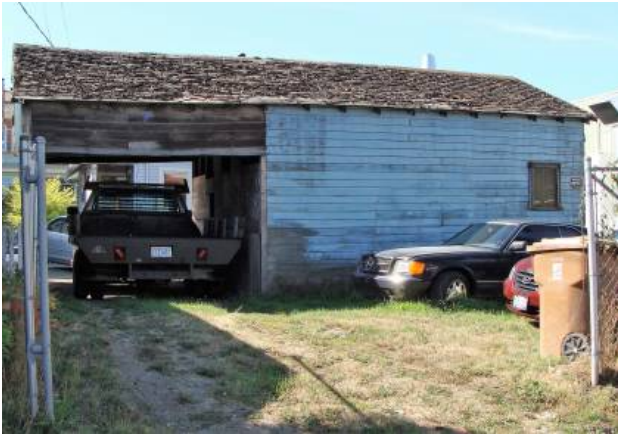
3721 N. 27th St., accessory bldg., 2019
