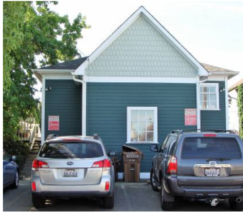
Rear facade, 3819 N. 25th St., 2019
